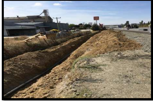
İstanbul Kavşağı Su İshale Hattının Deplasesi
