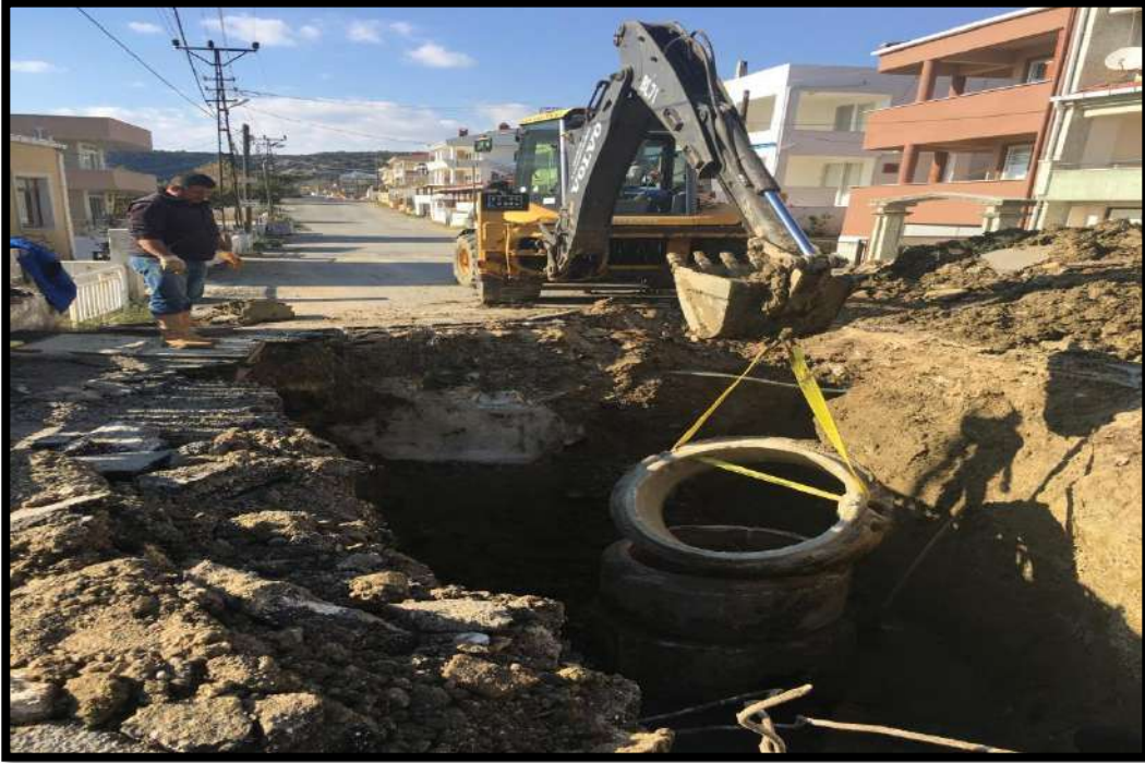
Yayla Liman Caddesi Kanalizasyon Çalışmaları
