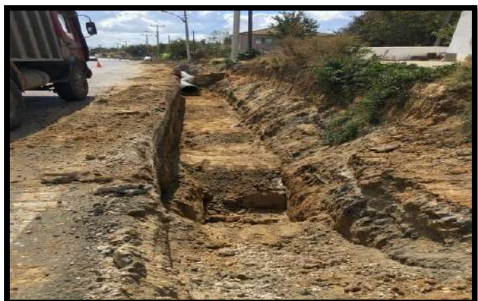
Paşayığıt Mah. Knlz. Şebeke Döşeme Çalışmaları
