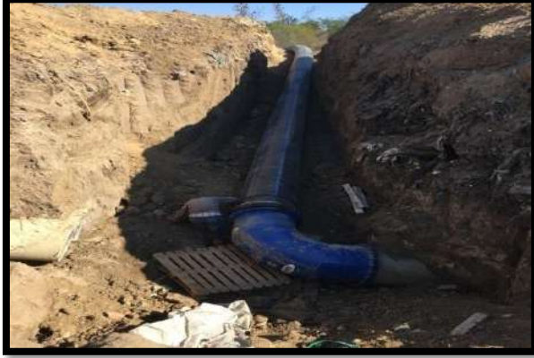
Kumdere Köyü Deplase İşi
