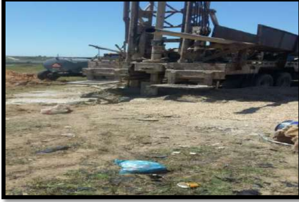
Kumdere Köyü arazilerinde Derin Sondaj su kuyusu açılması.
